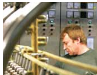
Versorgung (Bild oben)
